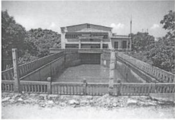
图 006：西安码头泵站出水渠道
