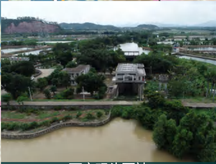
西安码头泵站
