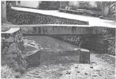
3 乾北石桥侧面
