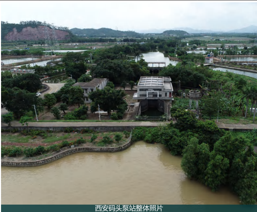
西安码头泵站整体照片
