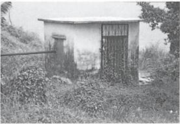
图 009：西安码头泵站管理房
