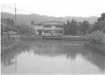
图 005：西安码头泵站引水渠和渠道
